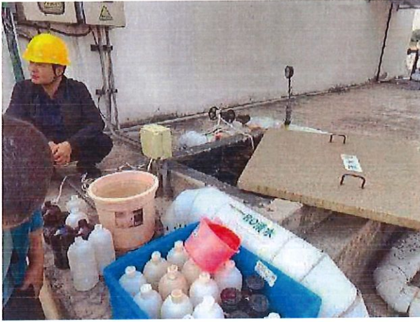
渗滤液处理站出口
